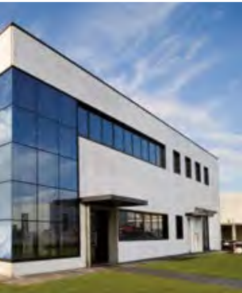
Site de production de Montecchio P. - 2007
